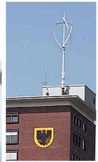
Rührt die Luft um: Vertikales Windrad auf dem Dortmunder Stadthaus. Geringer Wirkungsgrad, aber einfach in der Wartung, leise und städtetauglich. Kann den E-Fuhrpark versorgen.
