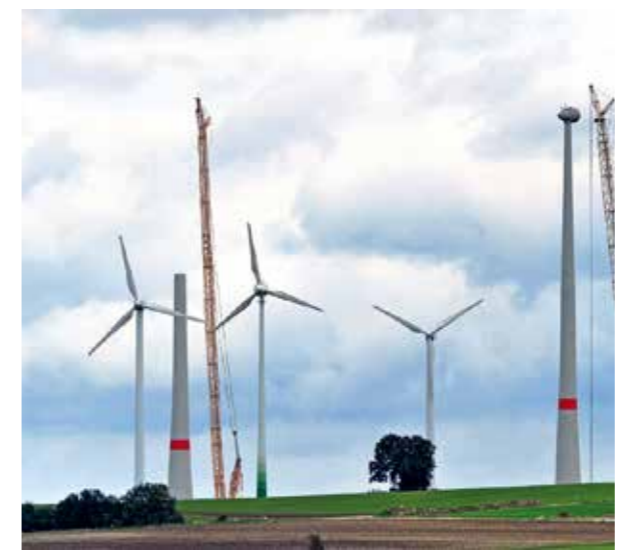
David und Goliath auf der Paderborner Hochfläche: Bis zur ausgestreckten Flügelspitze sind es 200 Meter (rote Banderole), die Minis mit den grünen Füßen sind nur halb so hoch.
