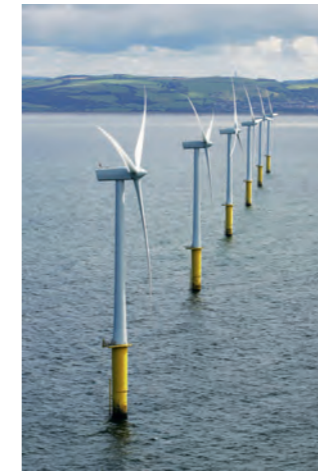
Nass im Wind: Der Offshore-Windpark North Hoyle in der Irischen See vor der Küste von Denbighshire, Wales. 30 Windräder mit 80-Meter-Rotoren leisten zusammen rund 60 MW. Inbetriebnahme 2004, unterstützt von Greenpeace, Vertrieb als „Ökostrom“.
