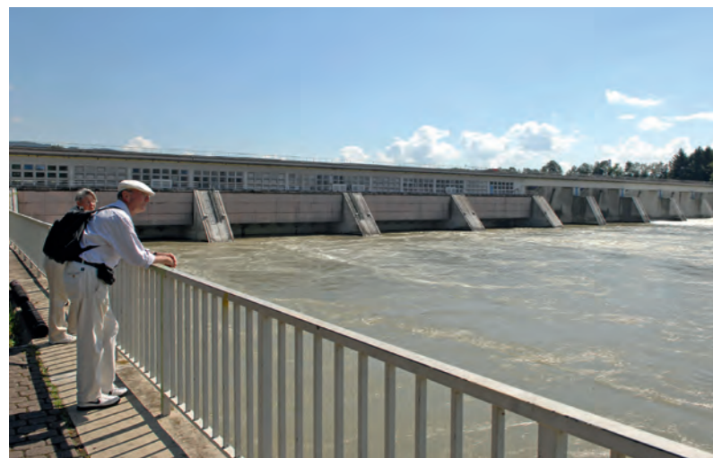
Alles fließt und strömt: Das Laufwasserkraftwerk Säckingen im Grenzgebiet zwischen Deutschland und der Schweiz drückt 73,6 Megawatt durch die Turbinen, eine Jahresleistung von 485 Millionen Kilowattstunden.
